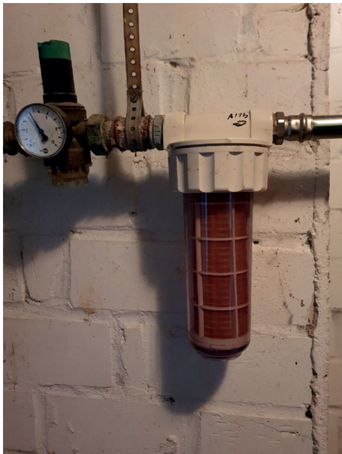
Abbildung 14: Filter verfügen über eine große Oberfläche an der sich entsprechend leicht mineralische Ablagerungen und Biofilme bilden können. Bei diesem Filter sind die Ablagerungen durch die rote Farbe deutlich zu erkennen. (© AGRAVIS Raiffeisen AG)
