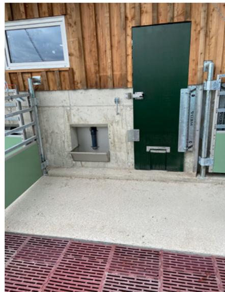
Abbildung 20: Auslauf einer Freilaufbucht mit planbefestigter Fläche sowie Kunststoffspalten (© Netzwerk Fokus Tierwohl, Landwirtschaftskammer NRW)
