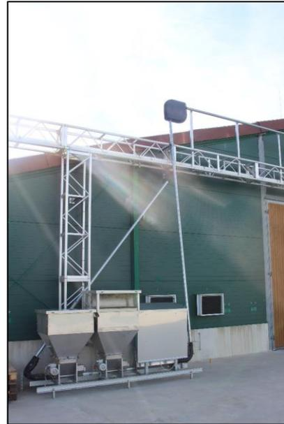
**Abbildung 8:** Vorratssilos mit Rührwerk und Rohrförderung außerhalb des Stalls.
