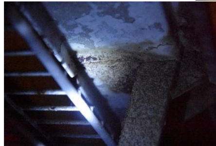
Mit Silikatstaub behandelte Stalleinrichtung (rechts)
